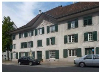
Hauptstrasse 34, Bad Zurzach
